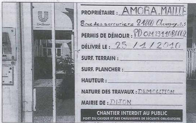
Les signes extérieurs de la démolition sont encore peu visibles. Photo Arnaud Frister
