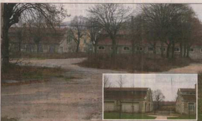
Le futur quartier Heudelet sera un éco-quartier sur l'emplacement des bâtiments à démolir derrière la communauté d'agglomération du Grand Dijon (photos BP-LD)
